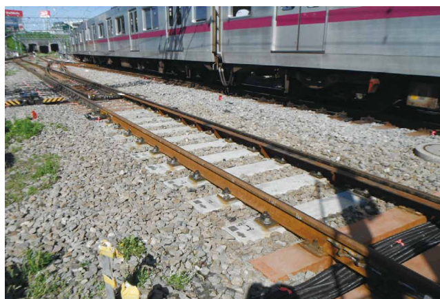
図2 分岐器付帯の直線部分
