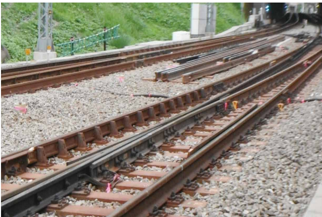
図4 内方分岐器のクロッシング部
