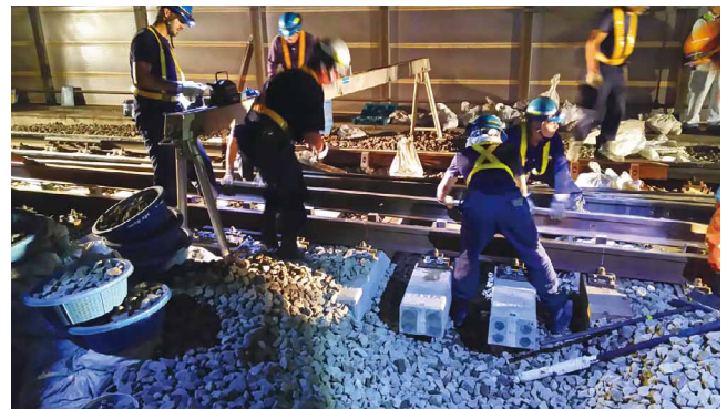
図5 交換工事風景
