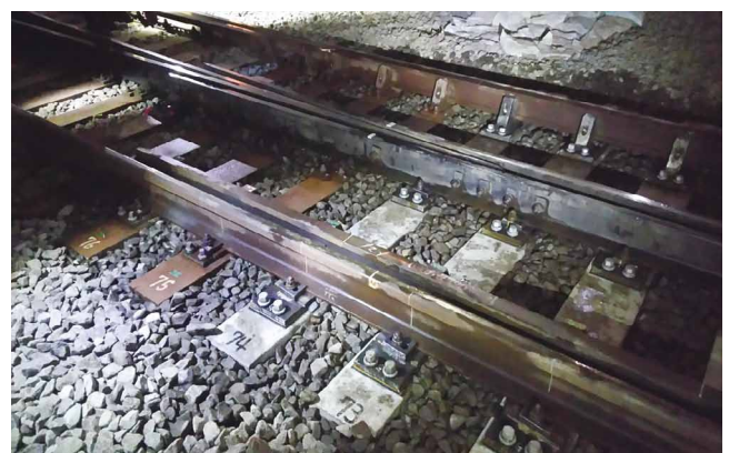
図6 一部PCまくらぎ化した状態 (工事途中)
