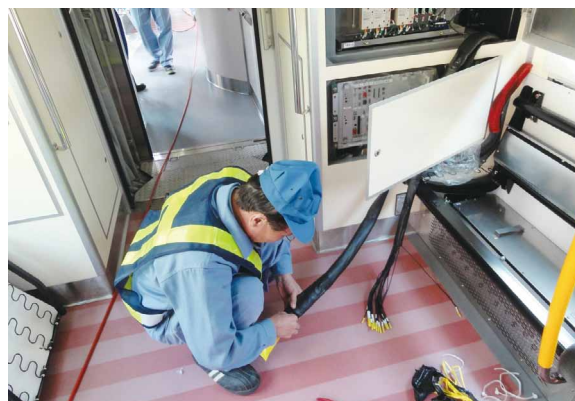
図8 予備線接続作業
