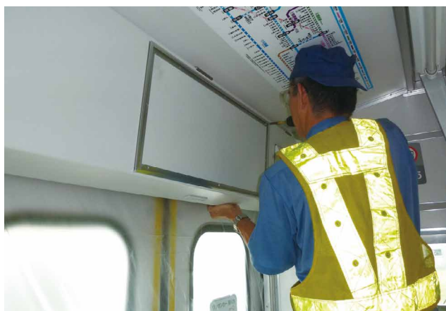
図7 取付作業(広告外し作業) (1)
