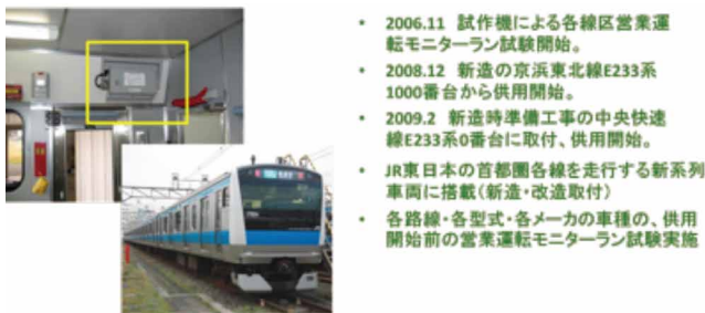
図7 JR 東日本向け防護無線自動発報装置普及状況 (9)
