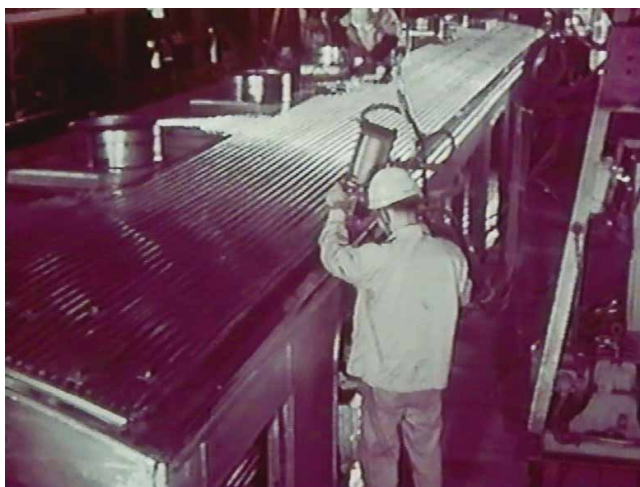
図6 屋根構体と側構体を結合する抵抗スポット溶接 (3)
