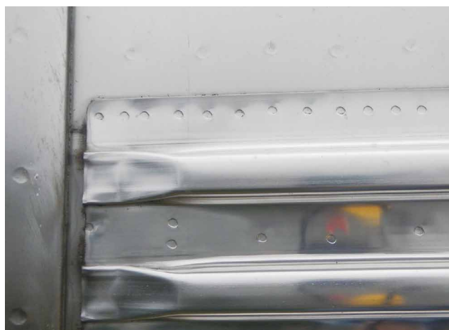
図9 側構体の抵抗スポット溶接の圧痕
