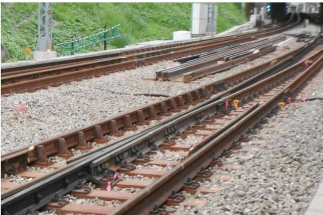
図4 内方分岐器のクロッシング部
