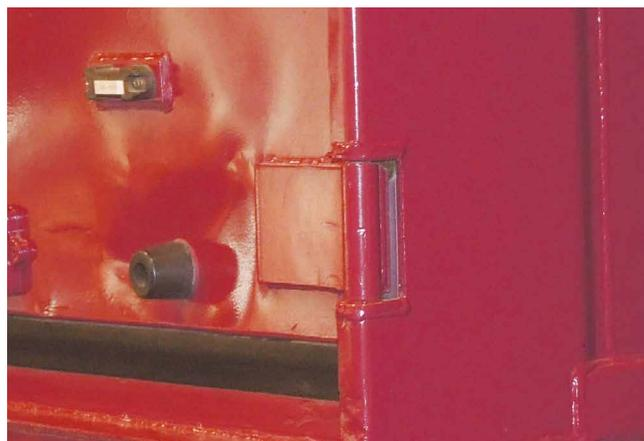
図9 溶接による外板とヒンジの接合
