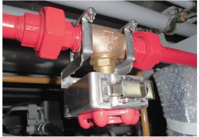
図5 燃料バルブ回り止め金具<sup>(1)</sup>
