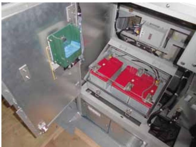
図 12 移動禁止システム専用蓄電池
