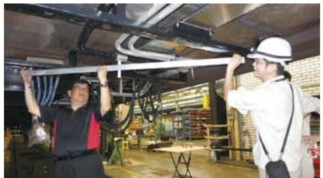
図7 機器吊り金具の平面度の確認作業
