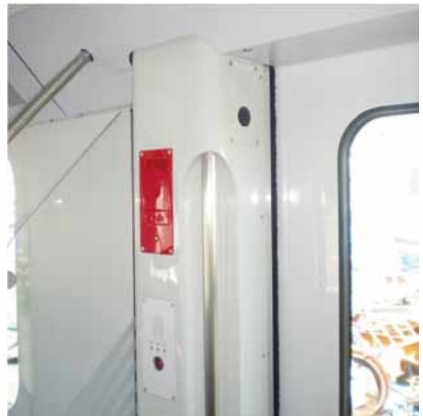
図4 車内解錠ハンドル周辺 （解錠ハンドル(左上) 非常通報器(左下) 戸閉案内(右上)）
