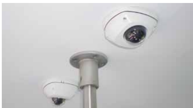
図6 客室内天井に搭載されるCCTVカメラ
