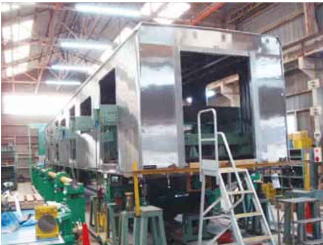
図6 構体荷重試験の実施状況
