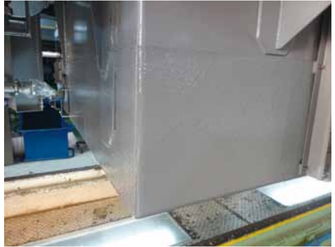
図5 燃料タンク防爆塗装
