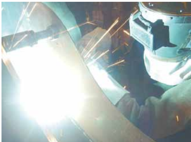
図7 製品におけるレ形開先の溶接
