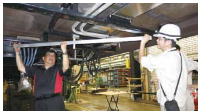
図7 機器吊り金具の平面度の確認作業
