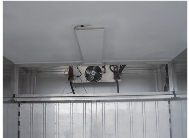
図5 天井ダクトと冷凍機エバポレータ
