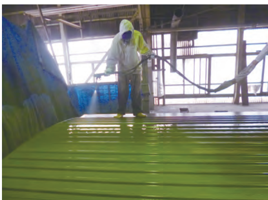
図3 屋根絶縁塗料塗布作業
