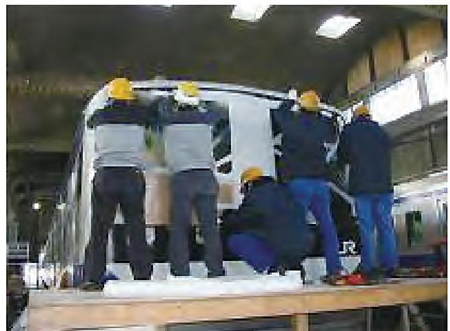
図5 前面ガラス交換作業
