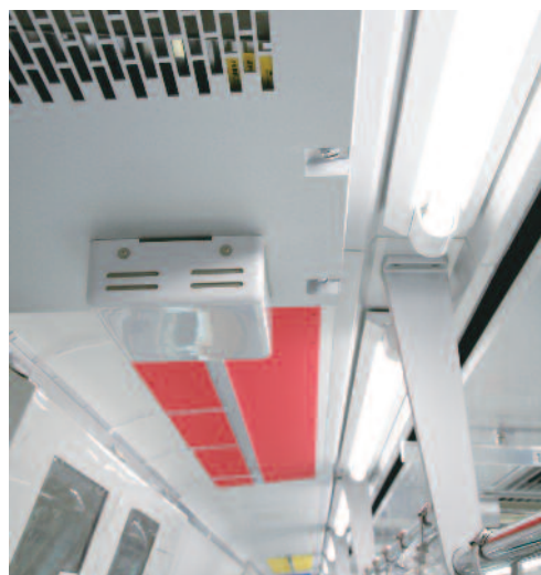
図10 LED照明とWi-Fiアンテナ
