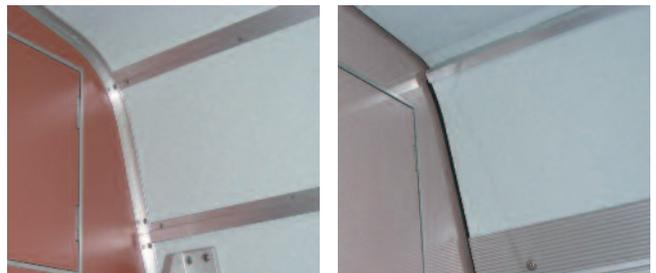
図1 妻部の押面構造（左）と目地構造（右）
