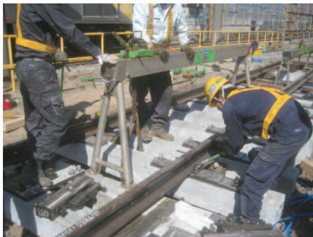
図11 敷設作業状況
