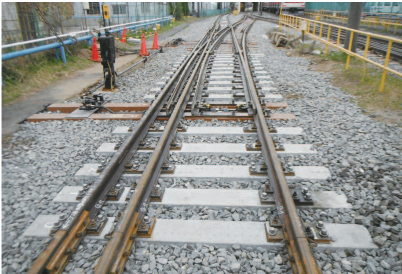
図1 製品敷設状態 (横浜事業所構内三線式分岐器のポイントより前方部分)
