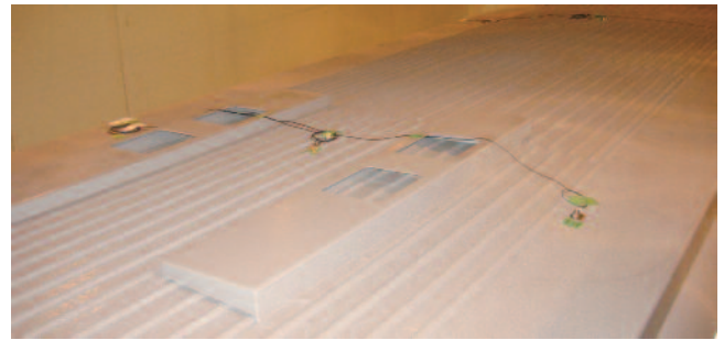
図4 加速度センサ 屋根測点設置状況
