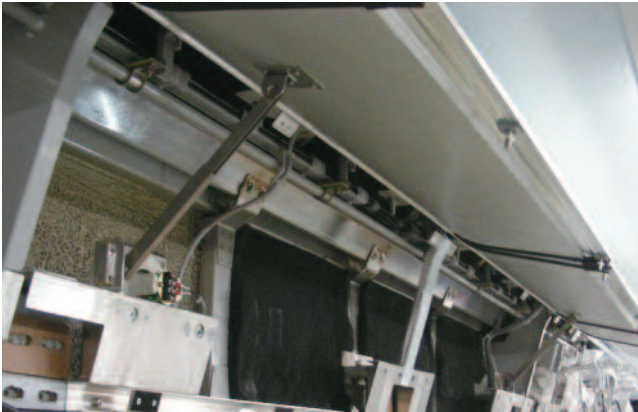
図12 荷棚上側天井用点検ふた（開放時）
