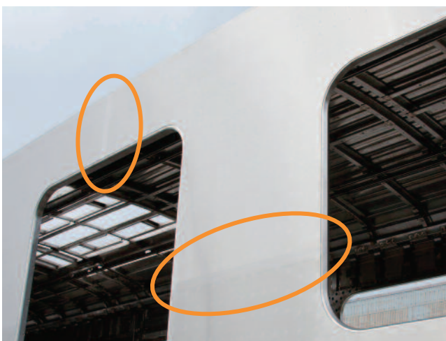
図6 外板接合部仕上げ後（橙色楕円内）
