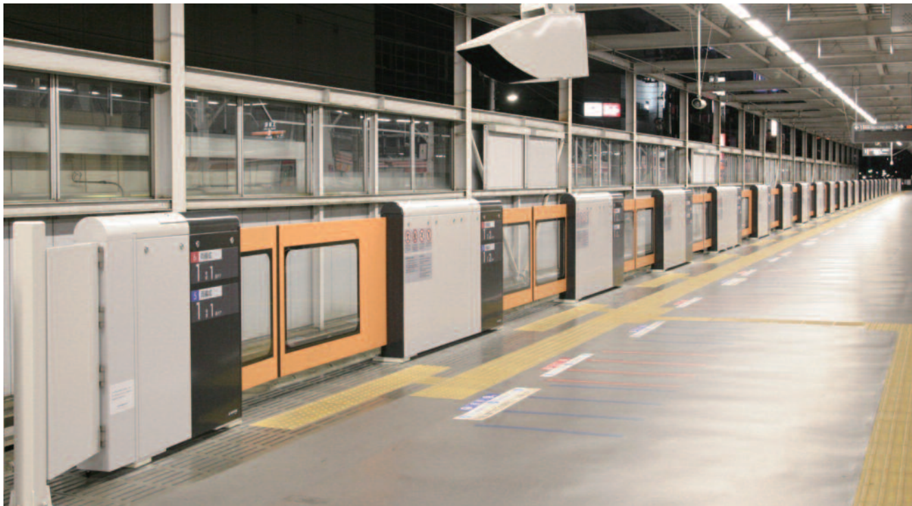
図1 大井町駅1番線側UDホームドア
