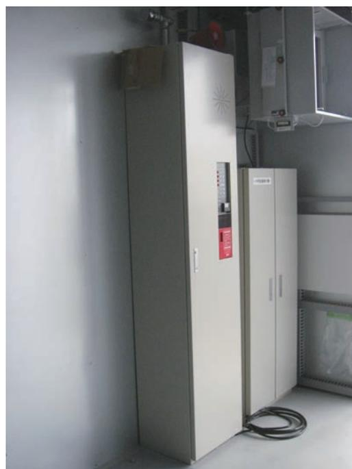
図7 付帯設備操作盤部および自動消火装置部
