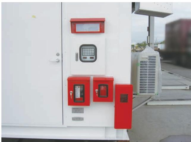
図3 付帯設備操作・表示部および自動消火設備操作箱
