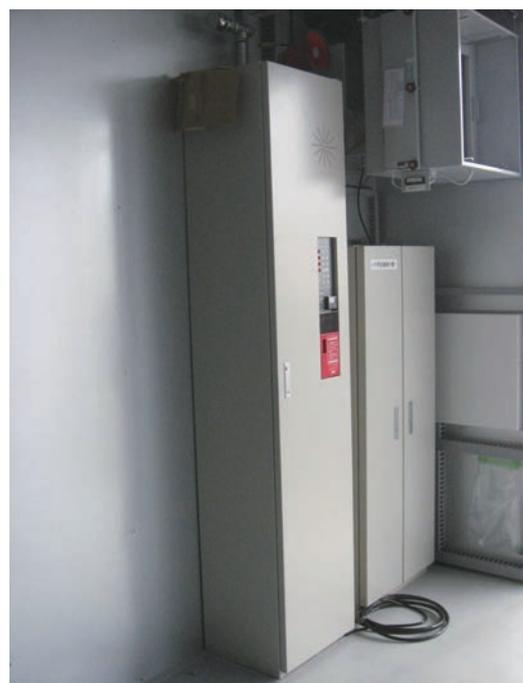
図7 付帯設備操作盤部および自動消火装置部
