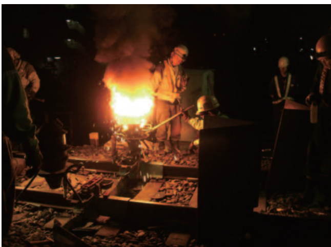
図6 敷設時の前後レールとの溶接作業
